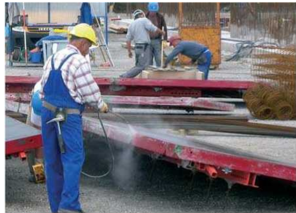
Obrázek 2 - Aplikace uvolňovacího prostředku postřikem
