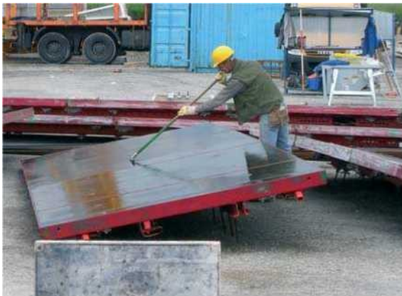
Obrázek 1 - Rovnoměrné nanášení separačního prostředku gumovou stěrkou
