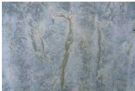
Obrázek 4 - Zbarvení v důsledku předávkování uvolňovacího činidla
