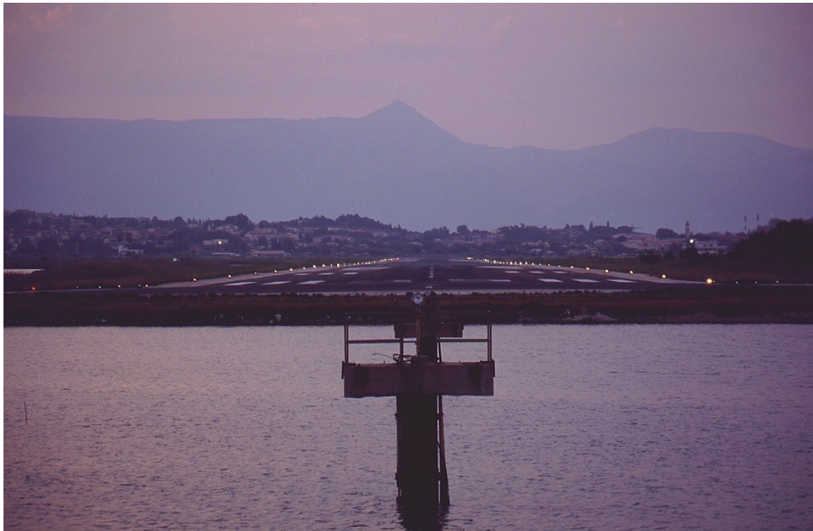
Figura 1 — Pista de aeródromo com luzes laterais elevadas
