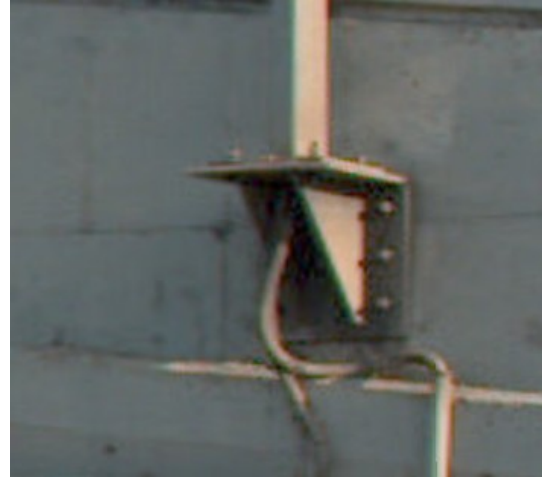
Εικόνα 4: Χαλύβδινη διάταξη στήριξης ιστού σε όψη τοίχου
