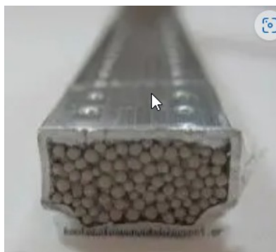
Rysunek 1 – Standardowa aluminiowa ramka dystansowa wypełniona krzemianami
