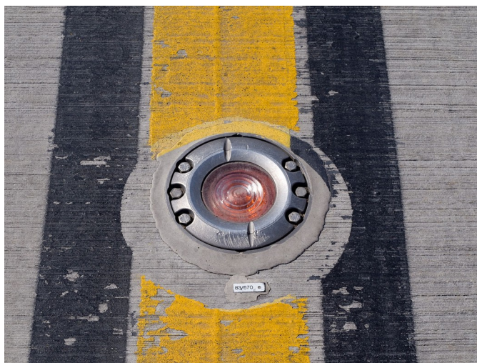
Εικόνες 2 και 3 - Παραδείγματα χωνευτών φανών διαδρόμων αεροδρομίου.
