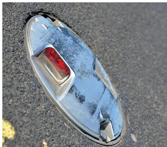
Εικόνες 2 και 3 - Παραδείγματα χωνευτών φανών διαδρόμων αεροδρομίου.
