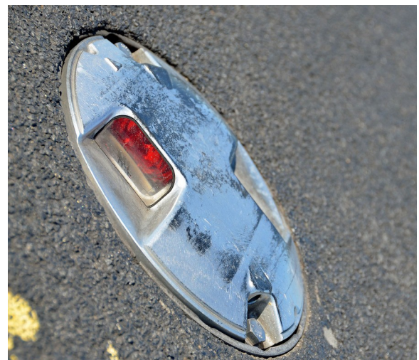
Kuvat 2 ja 3 – Esimerkkejä lentokentän kiitotiehen upotetuista valaisimista.
