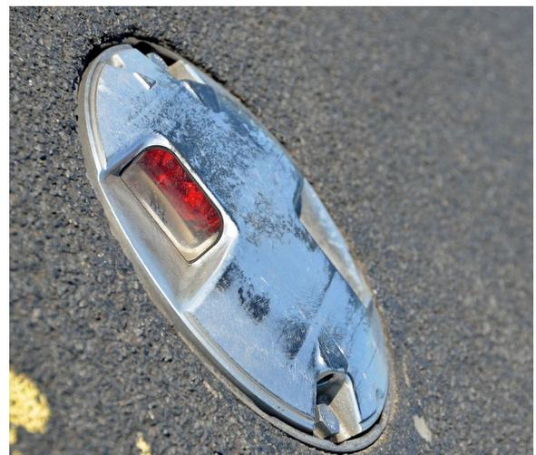
**Figure 2 e 3 — Esempi di apparecchi di illuminazione incassati per piste d'aviazione.**
