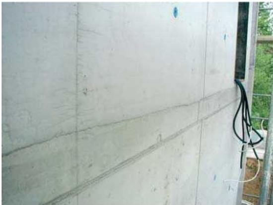
**Figura 7 - Junta de construcción de cara vista (no aceptable)**
