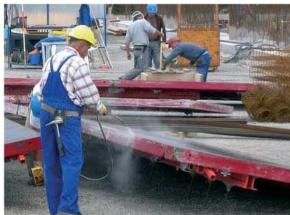
Slika 2. – Nanošenje sredstva za odvajanje prskanjem
