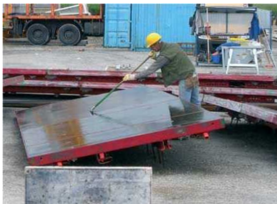
Slika 1. – Ujednačeno nanošenje sredstva za odvajanje s gumenom zidarskom žlicom
