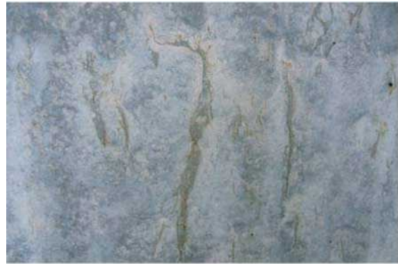
Slika 4. – Neujednačena boja zbog predoziranja sredstva za odvajanje
