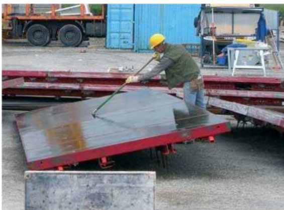
Slika 1 – Enakomeren nanos sredstva proti sprijemanju z gumijasto lopatico
