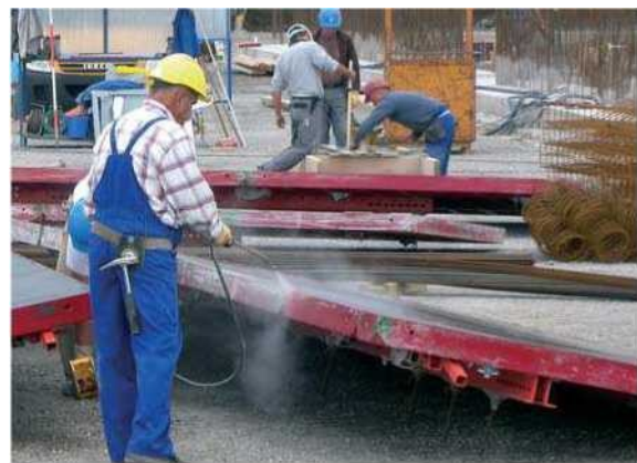
Slika 2 – Nanos sredstva proti sprijemanju s škropljenjem
