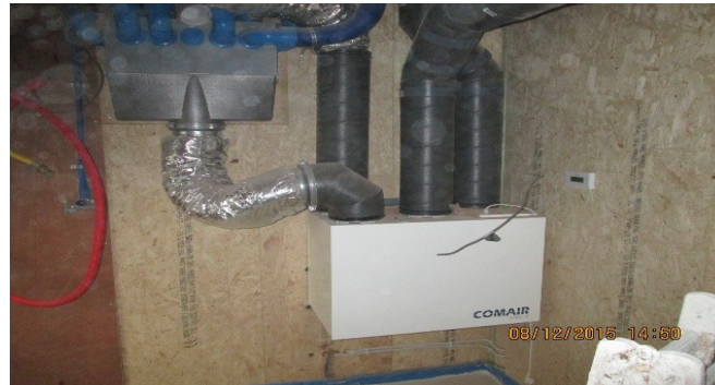
Figure 231: Unité de ventilation pour alimentation et rejet mécanique avec récupération de chaleur
