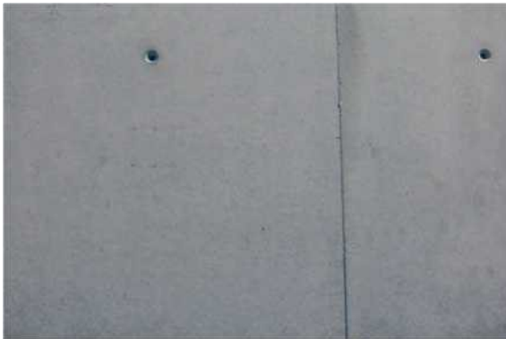
Εικόνα 3 - Η σωστή δοσολογία του αποκολλητικού είναι ομοιόμορφη
