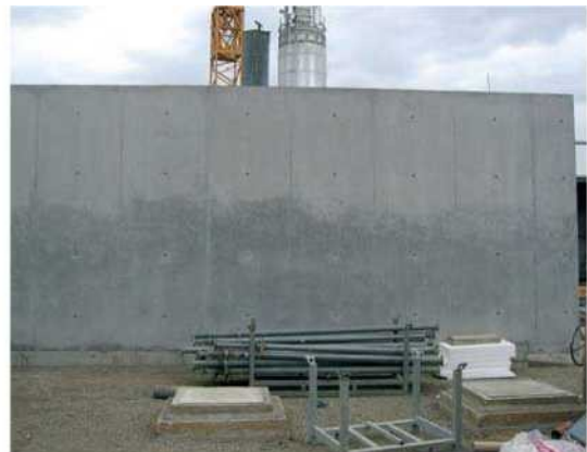
Εικόνα 8 - Εμφανής διαφορά απόχρωσης (μη αποδεκτή)
