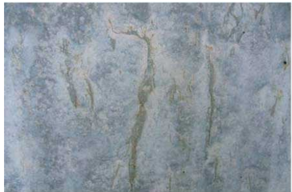
Εικόνα 4 - Χρωματικές αλλοιώσεις λόγω υπερδοσολογίας αποκολλητικού
