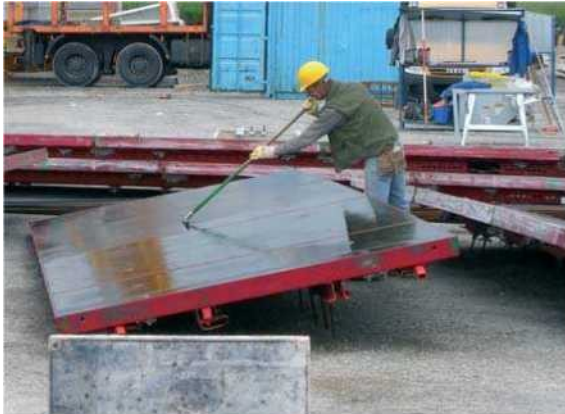
Εικόνα 1 - Ομοιόμορφη εφαρμογή αποκολλητικού με λαστιχένια σπάτουλα
