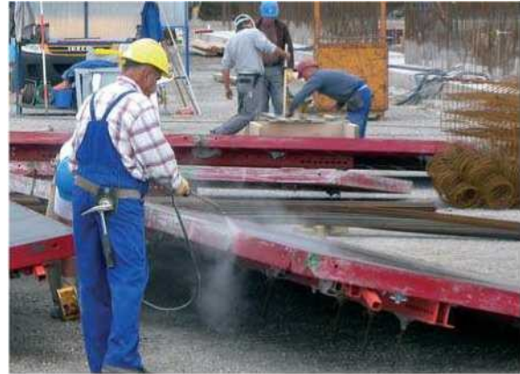
Εικόνα 2 - Εφαρμογή αποκολλητικού με ψεκασμό
