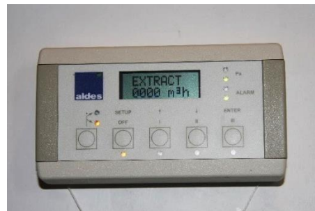
Figuur 70: Manuele schakelaars
