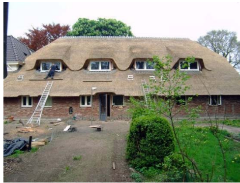
Figuur 81: Hellend dak in riet
