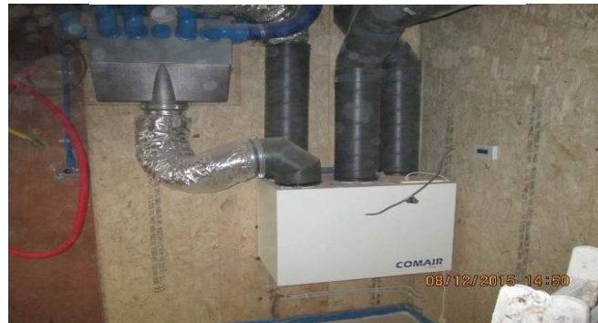
Figuur 225: Ventilatieunit voor mechanische toe-en afvoer met warmterecuperatie
