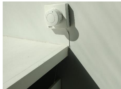
Figuur 60: Voorbeeld van een verplaatste thermostaatkraan
