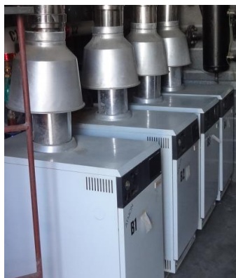
Figuur 30: Schema van een trekonderbreker (links) en voorbeeld van ketels met externe trekonderbreker/valwindafleider (midden) en toestel met open constructie (rechts).
