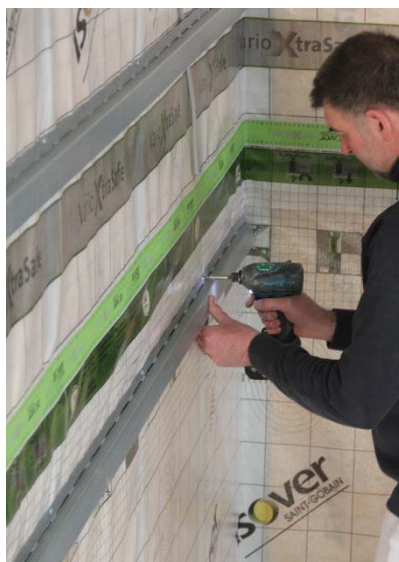
Figuur 55: Bevestiging van lattenstructuur
