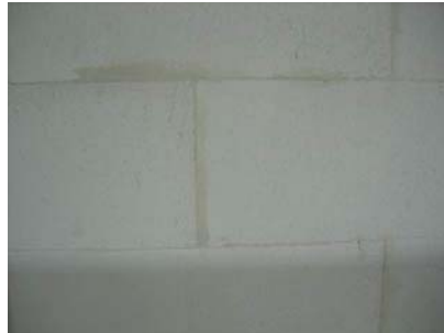
Figuur 68: Cellenbetonblokken van na de jaren '80
