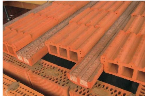
Figuur 75: Potten en balken
