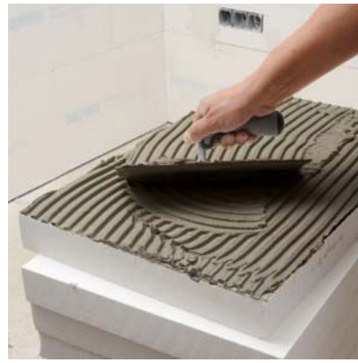
Figuur 54: Lijm op binnenisolatie
