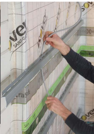
en) Figuur 56: Doorvoeren van leidingen door leidingenspouw
