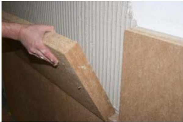
Figuur 53: Lijmen van binnenisolatie
