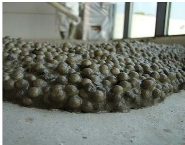
Figuur 72: Isolerende uitvullingslaag met EPS korrels
