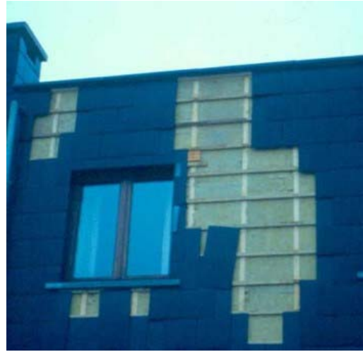
Figuur 62: Luchtlaag achter beplating
