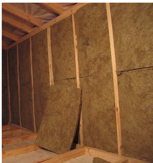
Figuur 52: Stijl- en regelwerk bij binnenisolatie: houten structuur
