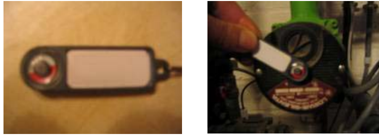
Figuur 163: Magneet om de werking van de circulatiepomp te controleren
