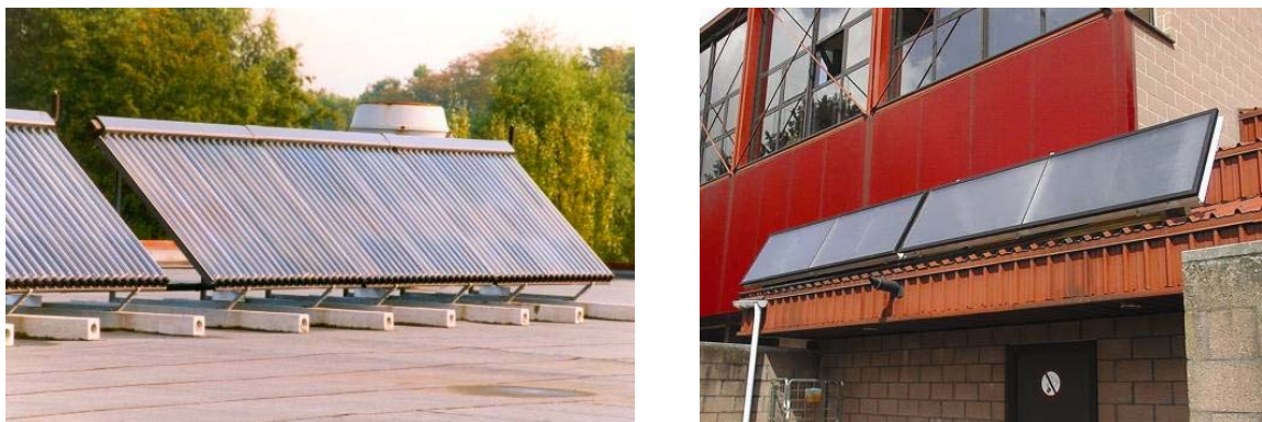
Figuur 236: Buiscollectoren (links) en vlakke plaatcollectoren (rechts)
