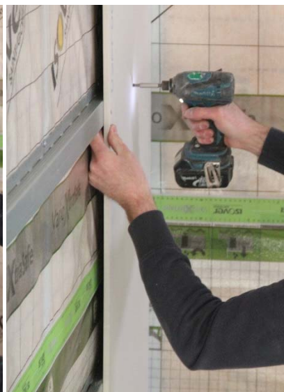
Figuur 57: Afwerkingsplaten op leidingenspouw
