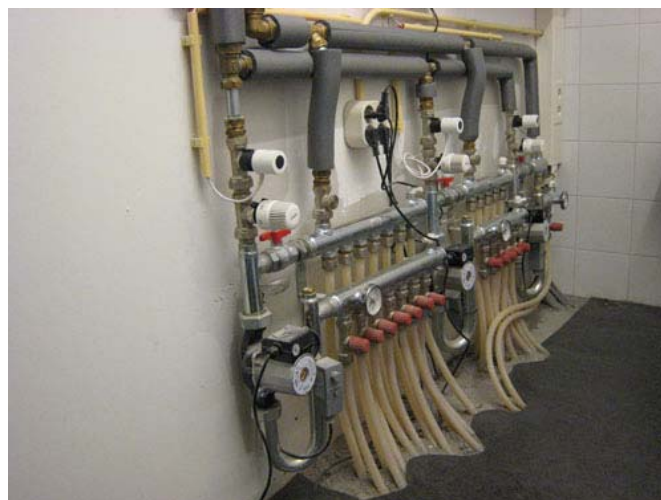
Figuur 199: Collector voor oppervlakteverwarming
