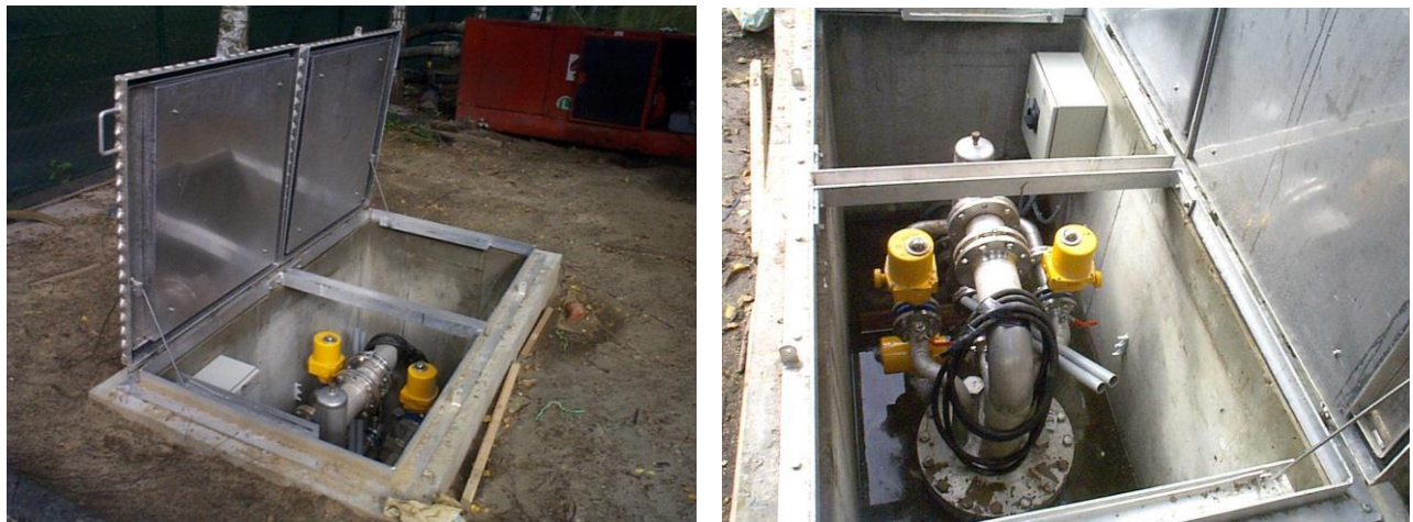
Figuur 44: Collectorput geo-cooling open systeem.
