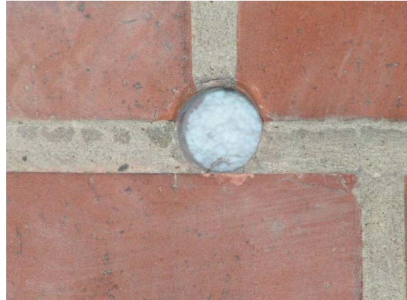
Figuur 65: Inblaasopening bij na-isolatie
