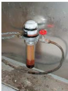
Figuur 123: Stookoliefilter met ontluchtingssysteem
