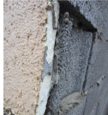
Figuur 60: Pleisterlaag (roze) op EPS (wit)
