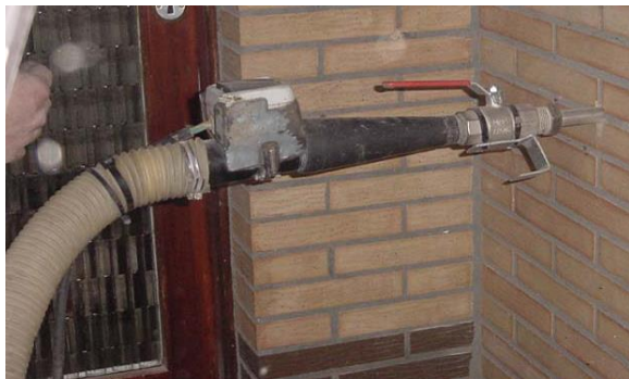
Figuur 100: Plaatsen van na-isolatie
