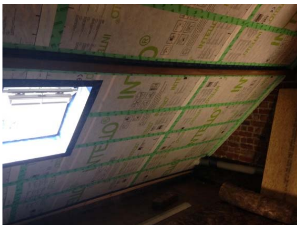
Figuur 71: Dampscherm bij een hellend dak
