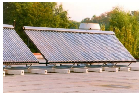
Figuur 35: Vacuümbuiscollector – CPC, principe (links) typisch uitzicht buiscollectoren (rechts)
