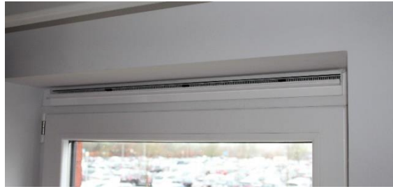
Figuur 47: Regelbare toevoeropening geïntegreerd in raamprofiel
