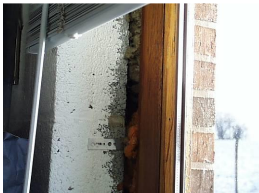
Figuur 96: Mogelijkheid om de samenstelling van de muur te inspecteren in een ruimte die niet helemaal klaar is, met name bij de aansluitingen van ramen, deuren of poorten
