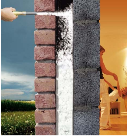
Figuur 64: Na-isoleren van traditionele spouw
