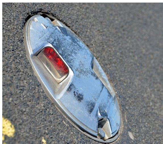
Figurile 2 și 3 – Exemple de corpuri de iluminat de inserție pe pista de aterizare.
