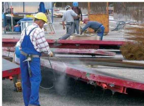
Figur 2 — Anvendelse af slipmiddel ved sprøjtning
