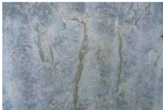
Figur 4 — Misfarvninger som følge af overdosering af slipmidlet
