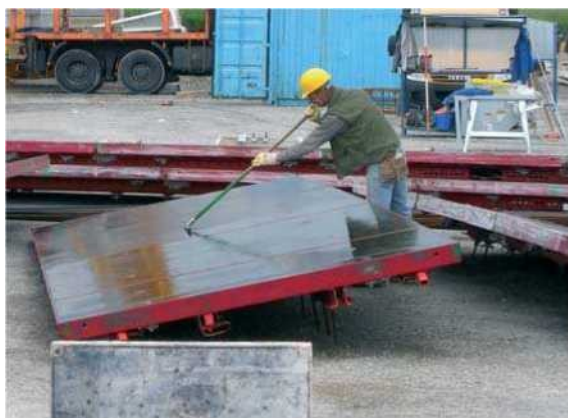
Rys. 1 – Jednolite nakładanie środka antyadhezyjnego gumową kielnią
