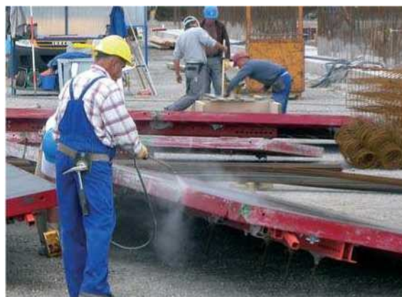
Rys. 2 – Nakładanie środka antyadhezyjnego przez opryskiwanie
