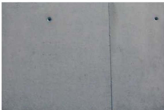
Rys. 3 – Prawidłowa dawka środka antyadhezyjnego jest niezbędna
