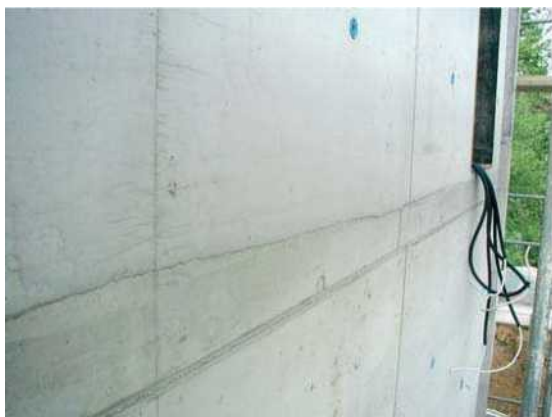
Rys. 7 – Złącze licowe (niemożliwe do przyjęcia)
