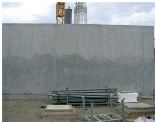
Rysunek 8 – Oczwista różnica kolorów (niemożliwe do przyjęcia)
