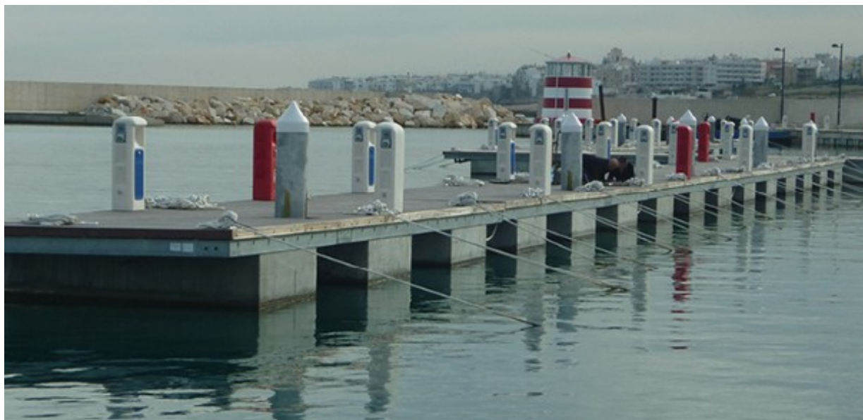
Figura 3: Sistema di ancoraggio galleggiante standard del pontile
