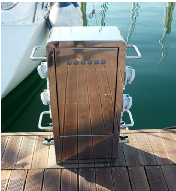
Figura 4: Cassetta di approvvigionamento idrico ed energetico
