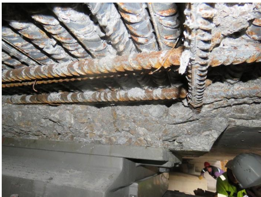
Slika 241: Gosta armatura prečnika ob in nad ležiščem.
