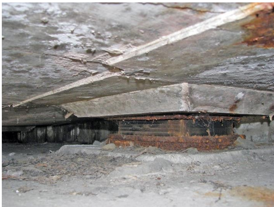
Slika 170: Neustrezno zreagiranje epoksidnega lepila, ki zato deluje kot mazivo v stiku.
