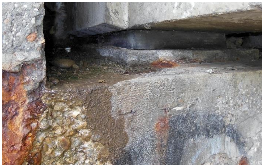
Slika 176: Stalno vlažno okolje zaradi netesne dilatacije. Propadanje ležiščne blazine.
