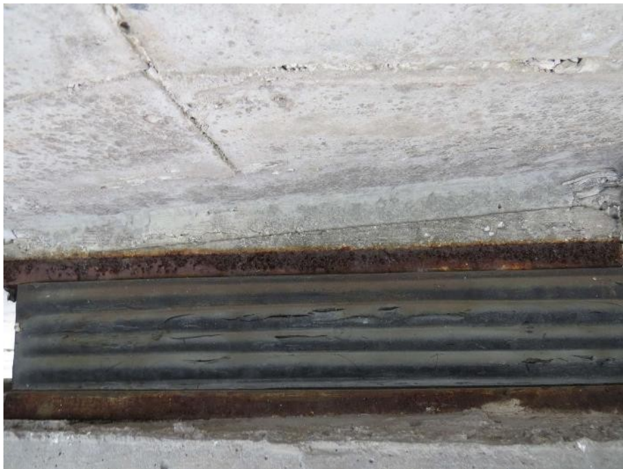
Slika 136: Neustrezne dimenzije ležiščnih plošč – plošče brez ustreznih previsov. Korozija ležiščnih plošč. Razpoke zaradi staranja in/ali lokalnih napetosti.
