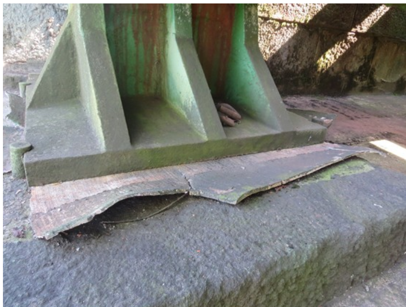
Slika 251: Iztiskanje svinčene plošče izpod linijskega nagibnega ležišča.
