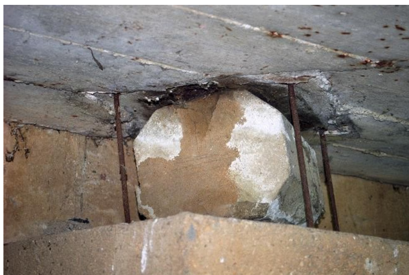
Slika 252: Betonsko valjčno ležišče.
