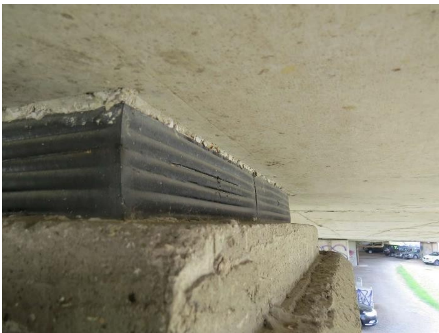
Slika 120: Razpoke elastomerja v nivoju jeklenih plošč.
