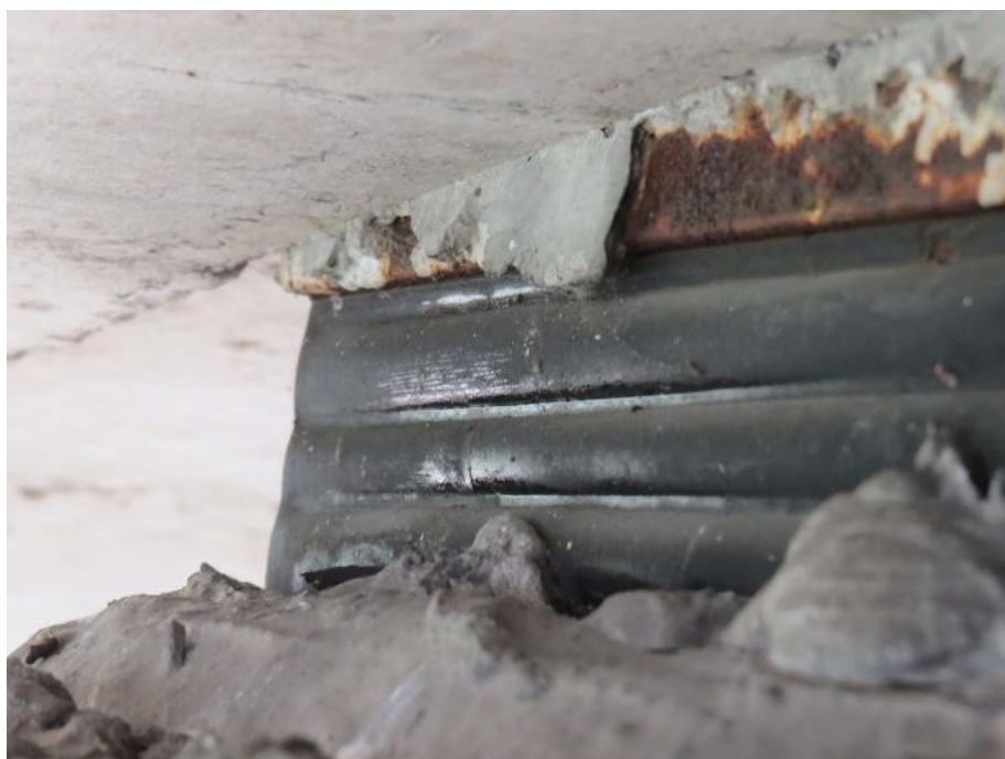
Slika 166: Pretanka debelina krovne plasti elastomerja.
