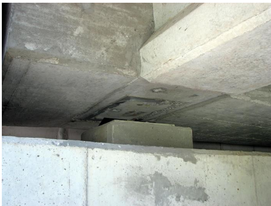
Slika 133: Izpadlo deformabilno drsno ležišče.
