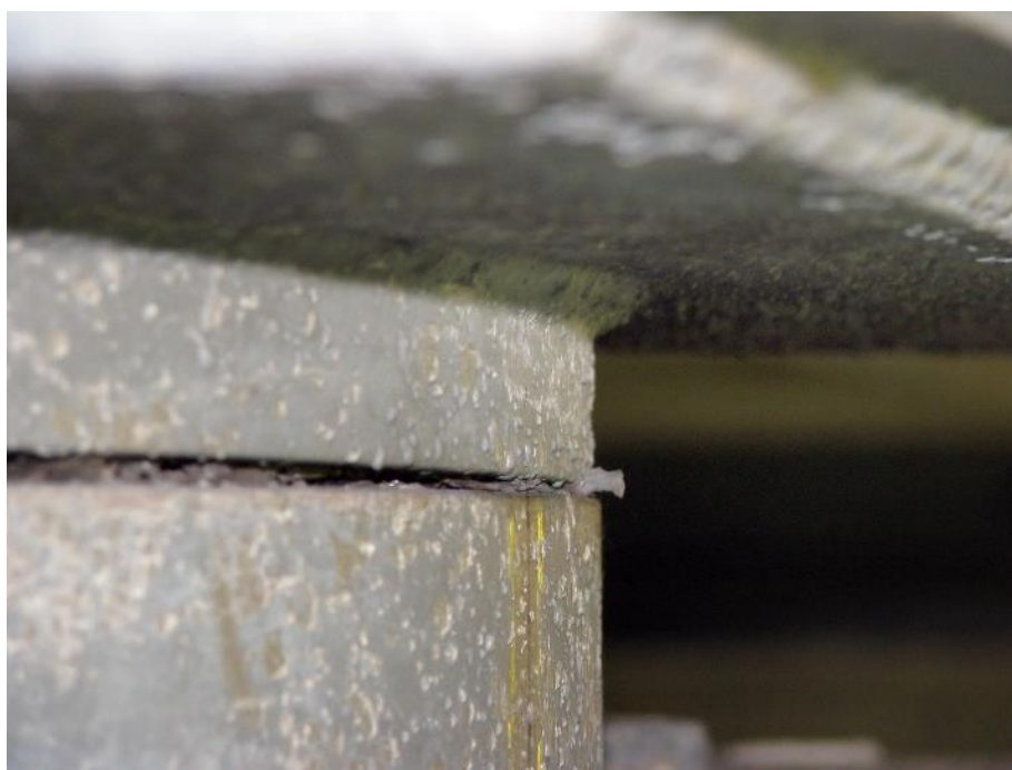
Slika 212: Premajhen razmik nagibne špranje med loncem in batnico lončnega ležišča.
