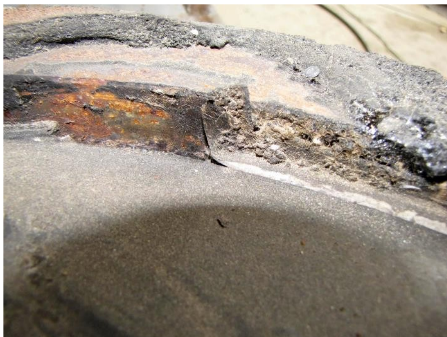
Slika 188: Lokalno mesto iztiskanja elastomerne blazine na robu lonca.
