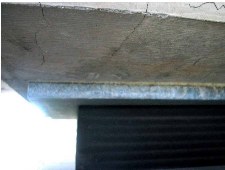
Slika 143: Razpoke v zgornji ležiščni blazini.
