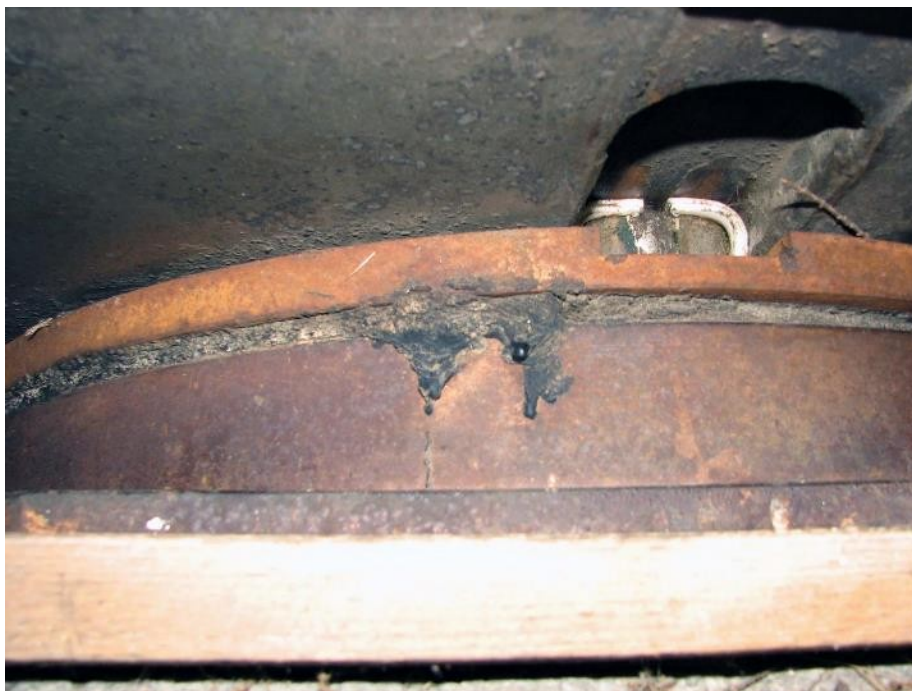
Slika 185: Iztiskanje teflonskega diska iz batnice v utor vzdolžnega vodila lončnega ležišča. Iztiskanje elastomerne blazine iz lonca.
