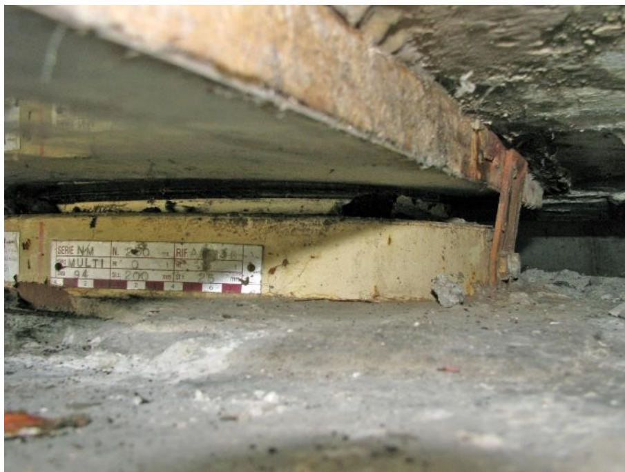
Slika 206: Iztiskanje elastomerne blazine iz lonca lončnega ležišča.
