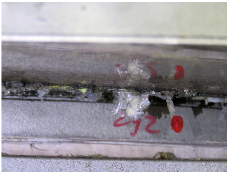
Slika 233: Struženje teflona drsnega diska lončnega ležišča.
