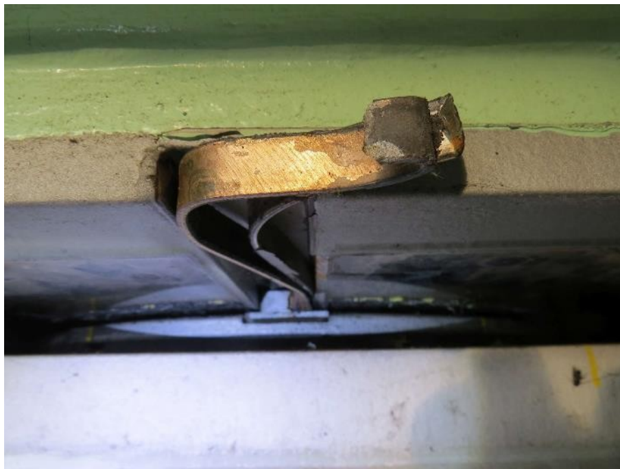
Slika 232: Iztiskanje bočnega drsnega traku in nerjavne pločevine centralnega vodila lončnega ležišča.
