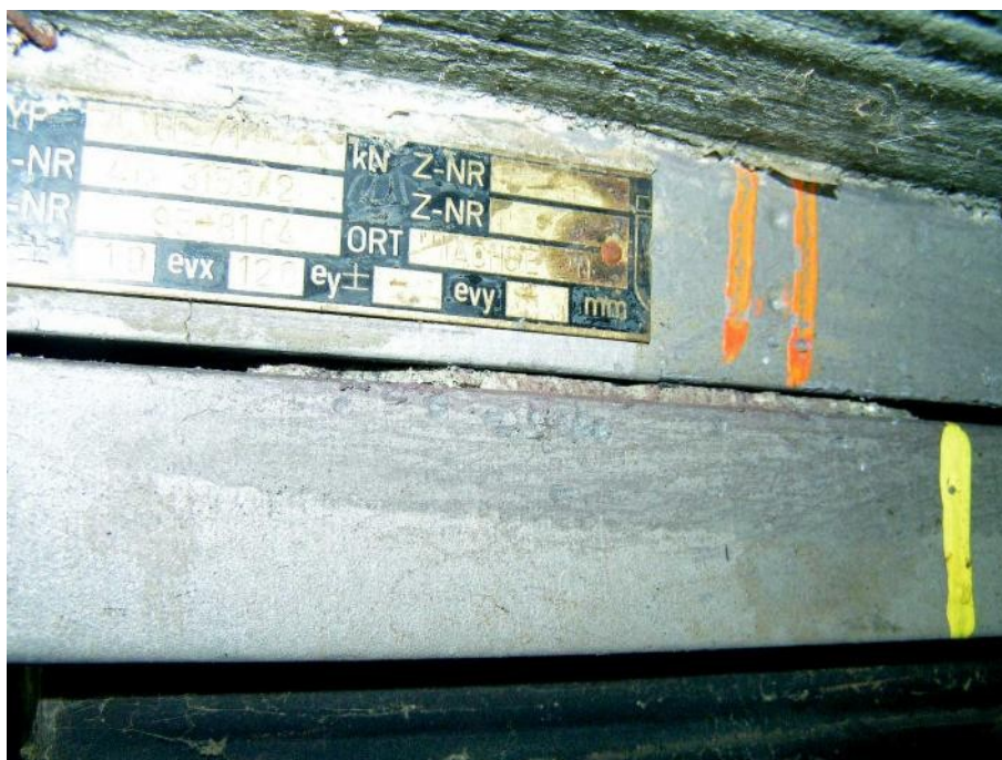
Slika 126: Betonska matrica v drsni špranji deformabilnega drsnega ležišča.
