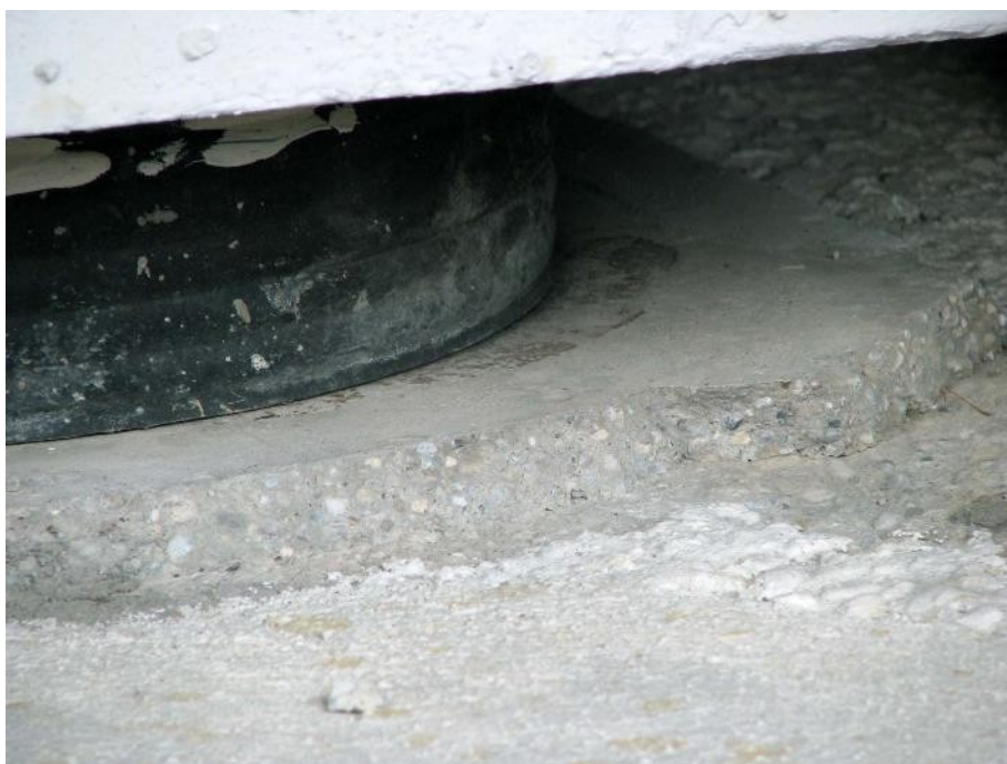
Slika 114: Zdrsavanje ležišča iz predhodne slike po ležiščni blazini iz malte.
