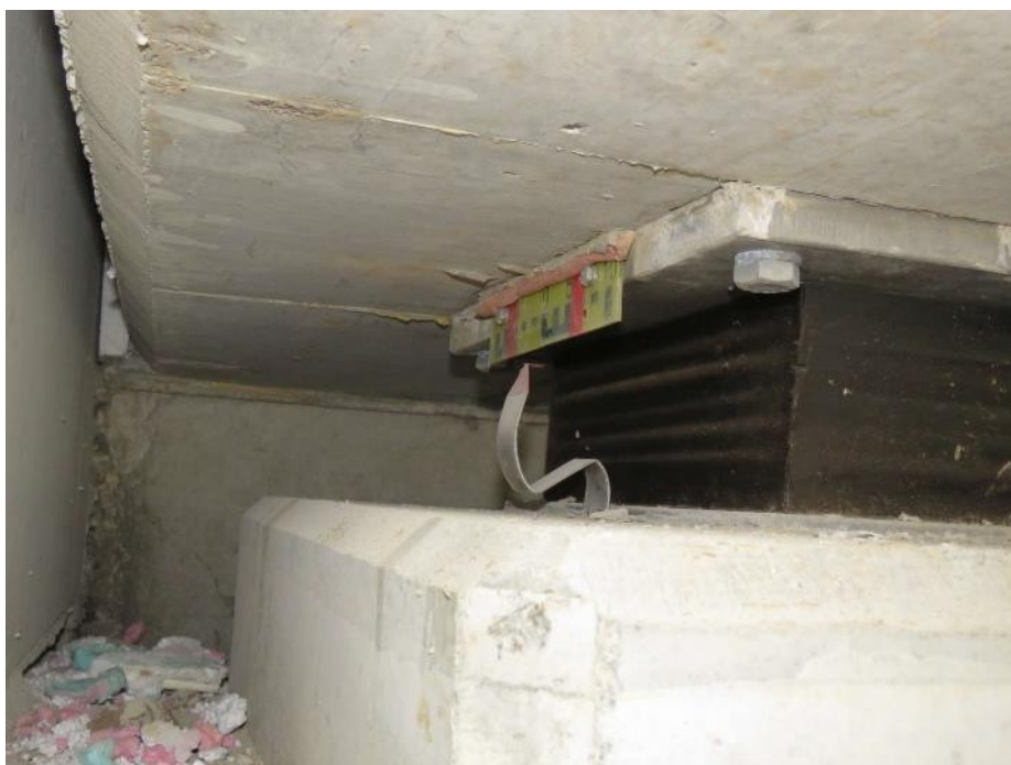
Slika 239: Deformiran kazalec pomikov.
