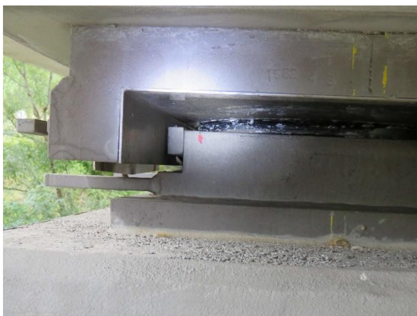
Slika 242: Iztiskanje MSM drsnega diska sfernega ležišča iz nosilnega ohišja.
