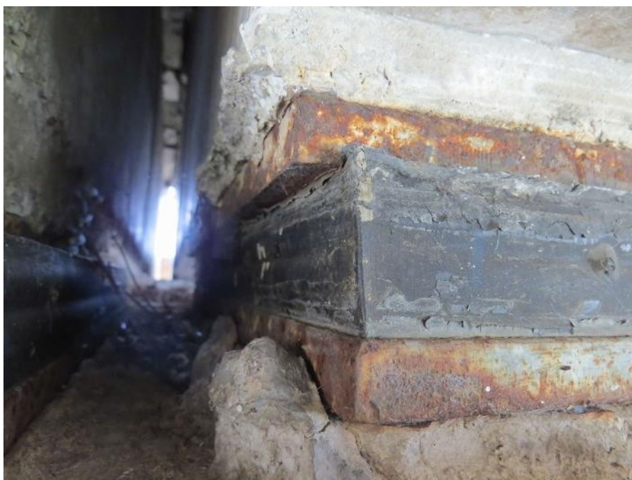
Slika 136: Neustrezne dimenzije ležiščnih plošč – plošče brez ustreznih previsov. Korozija ležiščnih plošč. Razpoke zaradi staranja in/ali lokalnih napetosti.
