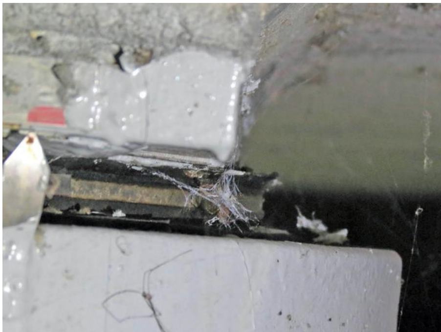
Slika 217: Prevelik pomik vodenega drsnega ležišča. Rob drsne plošče na drsnem disku.
