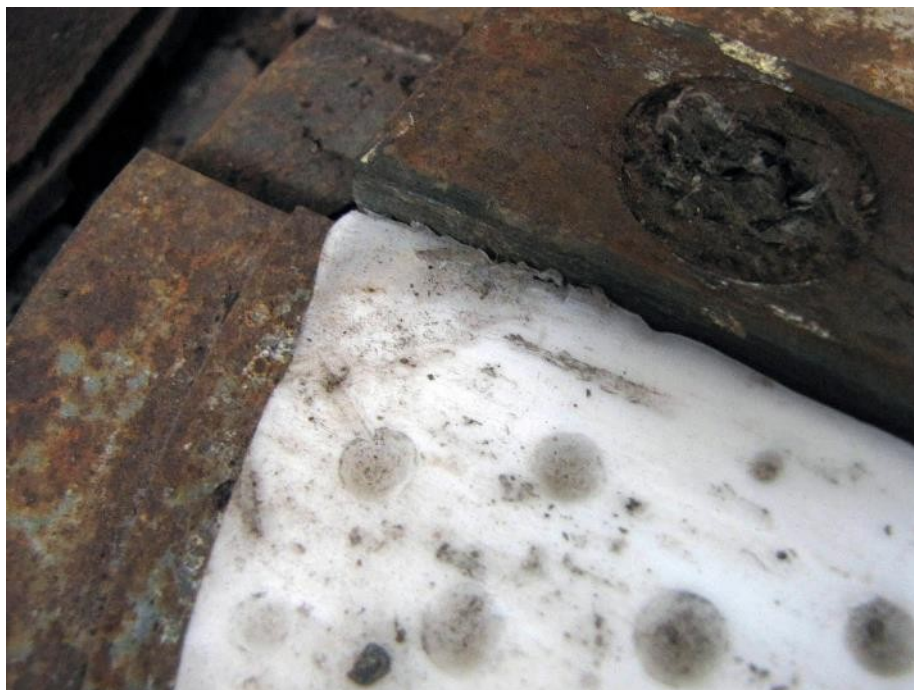
Slika 194: Pravilna usmerjenost žepkov teflonskega diska na batnici lončnega ležišča. Deformirani teflonski disk zaradi iztiskanja na robu utora diska ob vzdolžnem vodilu.
