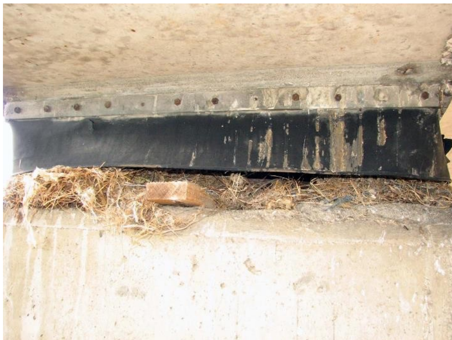
Slika 179: Ptičje gnezdo pod nezaščiteno drsno površino.
