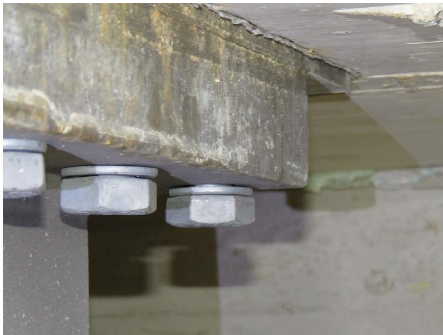
Slika 238: Neprivita sidrna vijaka.
