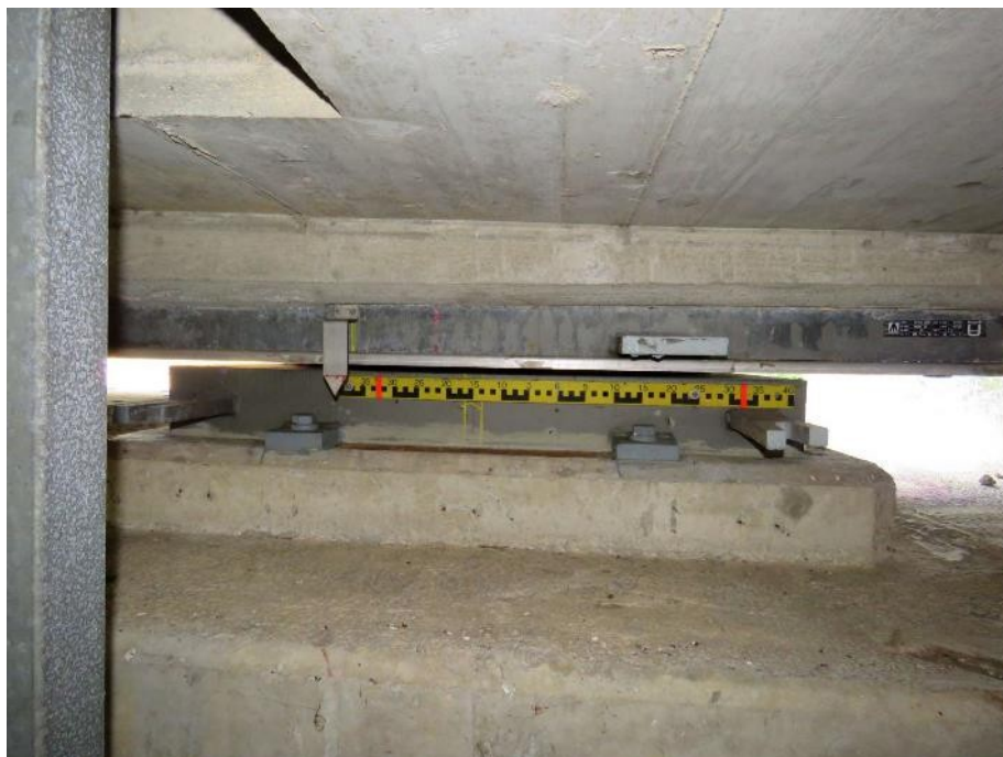
Slika 266: Napačno pritrjena merilna skala.
