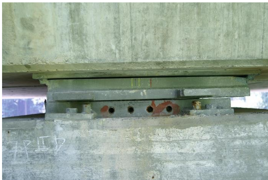
Slika 208: Kontakt bočnega vodila z loncem zaradi neustrezno podlitega ležišča.
