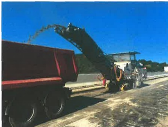
Slika 8.2: Priprava betonske površine c)
