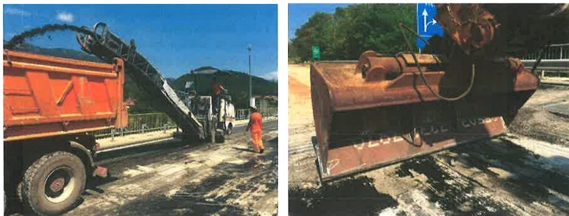
Slika 8.1: Priprava betonske površine a) in b)
