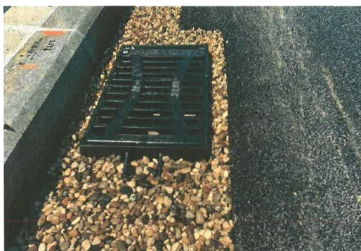
Slika 8.20: Drenažni filtrni žleb
