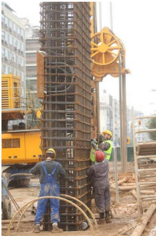
Εικόνες 6, 7 και 8 - Διαδικασία τοποθέτησης κλωβού οπλισμού
