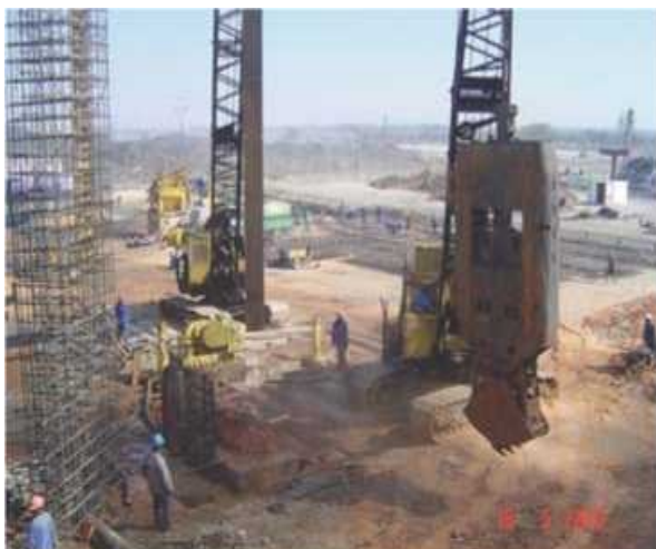
Εικόνα 3 - Αρπάγες μηχανικής λειτουργίας με συρματόσχοινο (μπένες)
