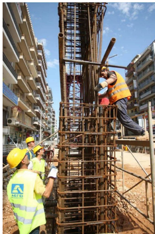
Εικόνες 6, 7 και 8 - Διαδικασία τοποθέτησης κλωβού οπλισμού
