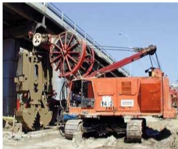
Εικόνα 3 - Αρπάγες μηχανικής λειτουργίας με συρματόσχοινο (μπένες)
