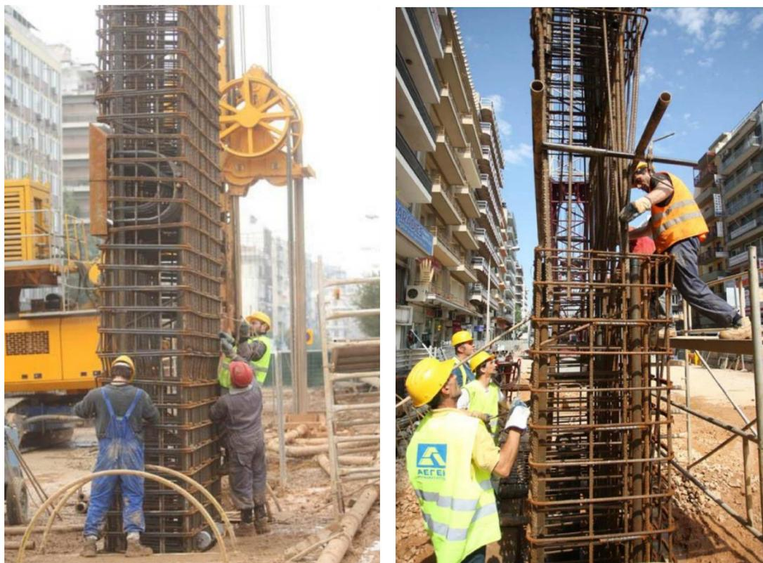
**Figuras 6, 7 y 8 — Procedimiento para colocar una jaula de armadura**
