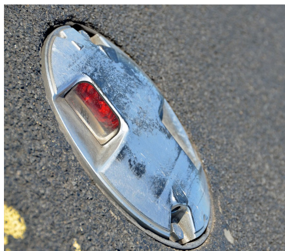
Slike 2. i 3. – Primjeri ugrađenih rasvjetnih tijela uzletno-sletne staze.
