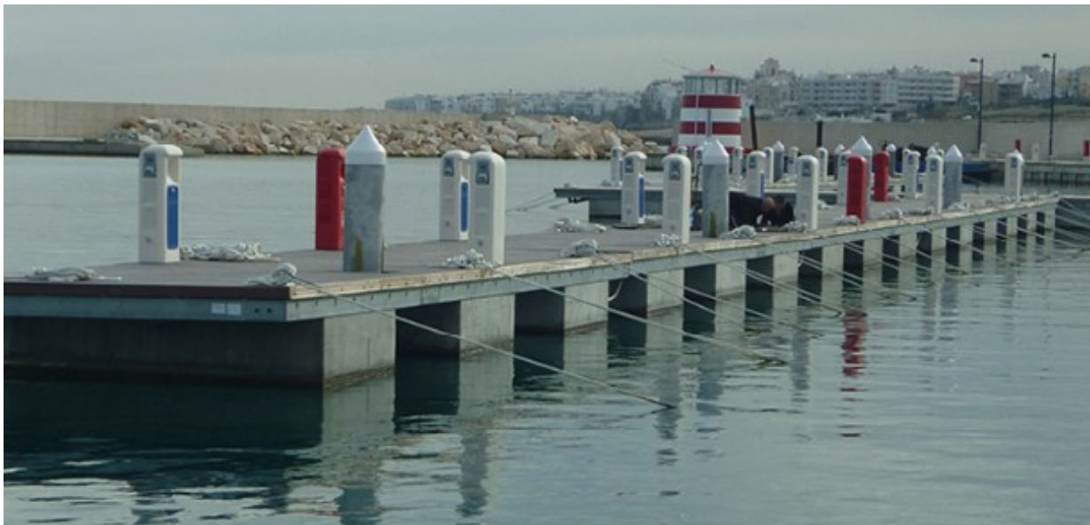
Figuur 3: Standaard verankeringsysteem drijvende pieren
