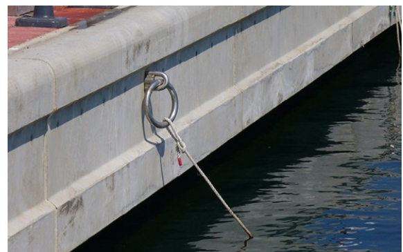
Figuur 2: Afmeerring van roestvrij staal
