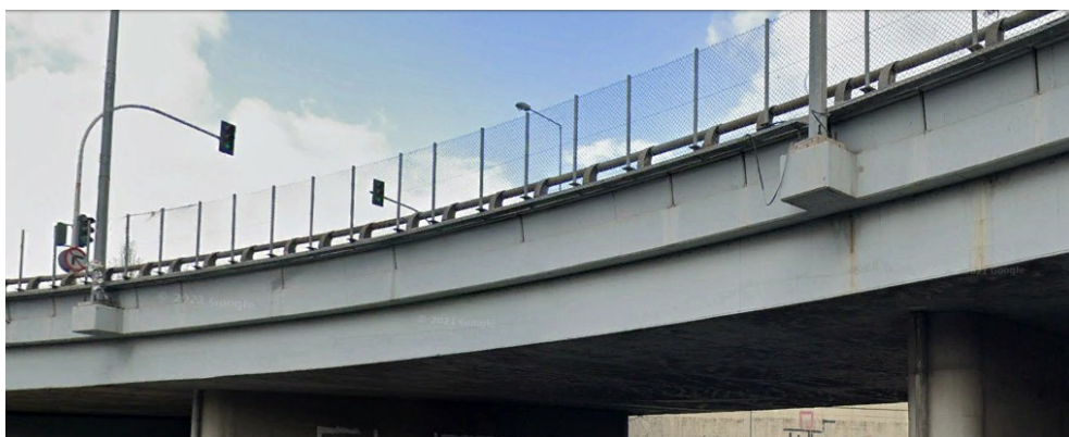
Фигура 3: Оформление на опорните бетонни елементи на стълбове за улично осветление, поставени на нови мостове и стени
