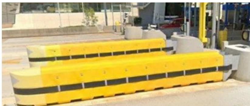
Фигура 2: Примерна схема на системи за поглъщане на енергия при сблъсък (CEAS)
