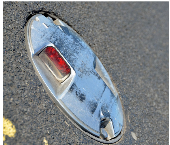
Figuras 2 y 3 — Ejemplos de luminarias instaladas en pistas de aterrizaje.
