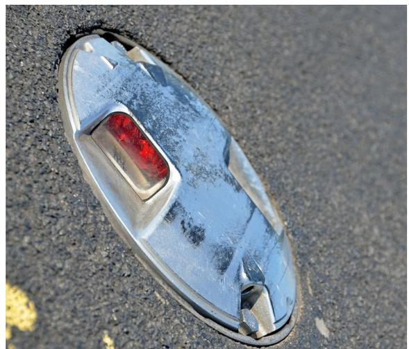
Figures 2 et 3 — Exemples de luminaires de piste d'aérodrome encastrés.
