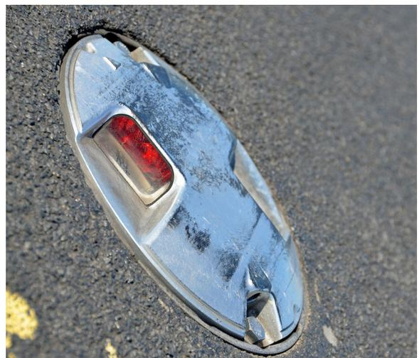
Figuras 2 e 3 — Exemplos de luminárias incrustadas de pista de aeródromo.
