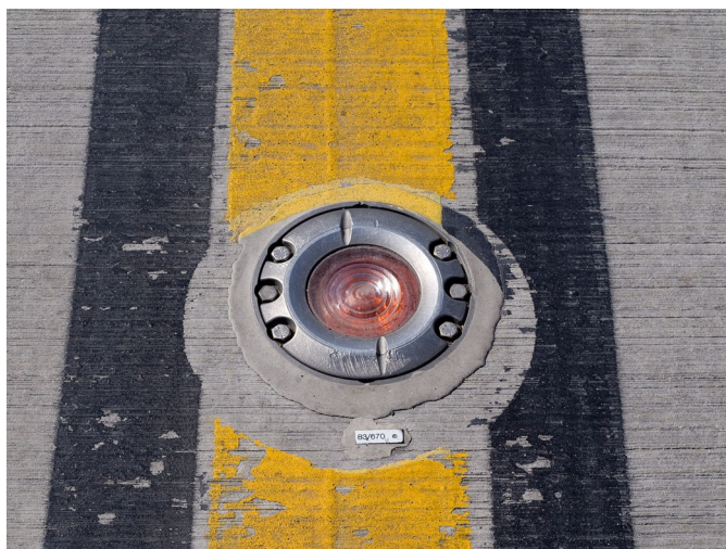
Sliki 2 in 3 – Primeri vgradnih svetilk za vzletno-pristajalno stezo.
