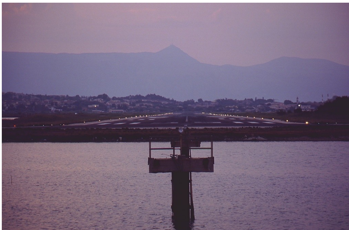
Slika 1. – Uzletno-sletna staza s povišenim bočnim rasvjetnim tijelima.
