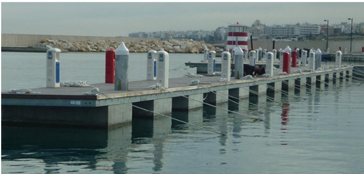
Figura 3: Sistema estándar de anclaje flotante del muelle
