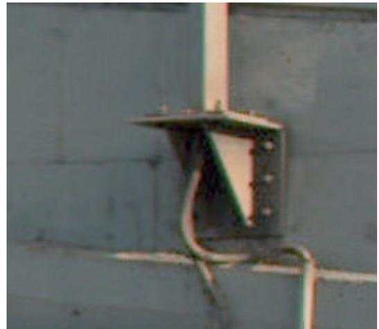
**Abbildung 4: Stahlmaststützvorrichtung in Wandansicht**
