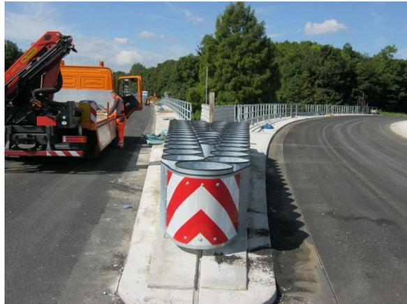
**Abbildung 1 – Systeme für die Energieabsorption im Crashfall (CEAS) auf einer Brücke im Spitzenbereich der Teilinseln montiert**
